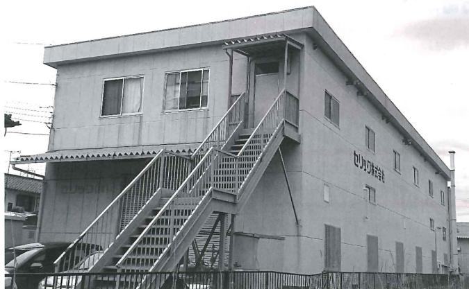
本社・テクニカルセンターの外観
